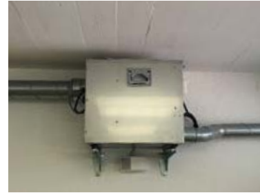
Das Lüftungsgerät entzieht dem Raum die Feuchtigkeit.
