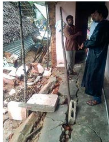
Nach dem Monsun waren viele Häuser erheblich beschädigt.
